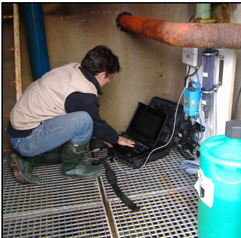
Pose d'un turbidimètre temporaire
