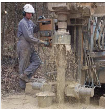
Forage d'un piézomètre
