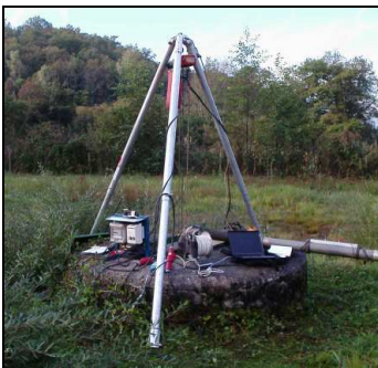
Pompage d'essai avec équipements
