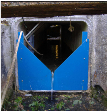
Pose d'un seuil temporaire
