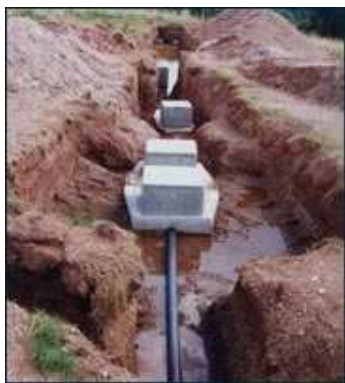
Contrôle avant recouvrement
